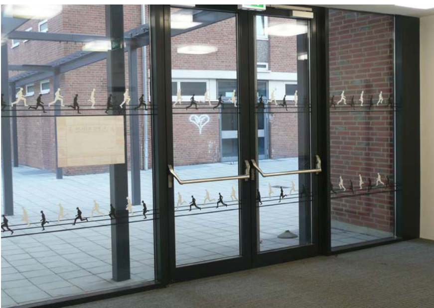
Abb. 7 Markierungen machen Glasflächen sichtbar und vermeiden so Unfälle.
